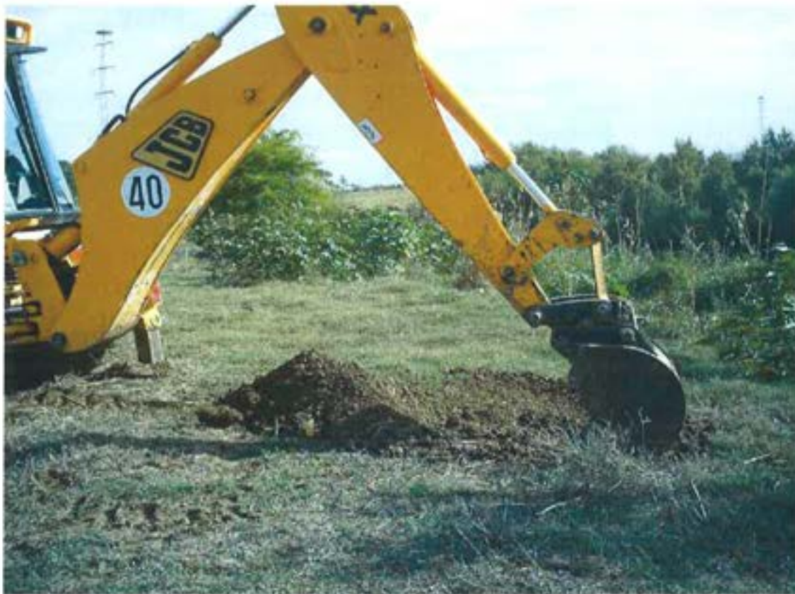
RETROEXCAVADORA ABRIENDO CALICATA
